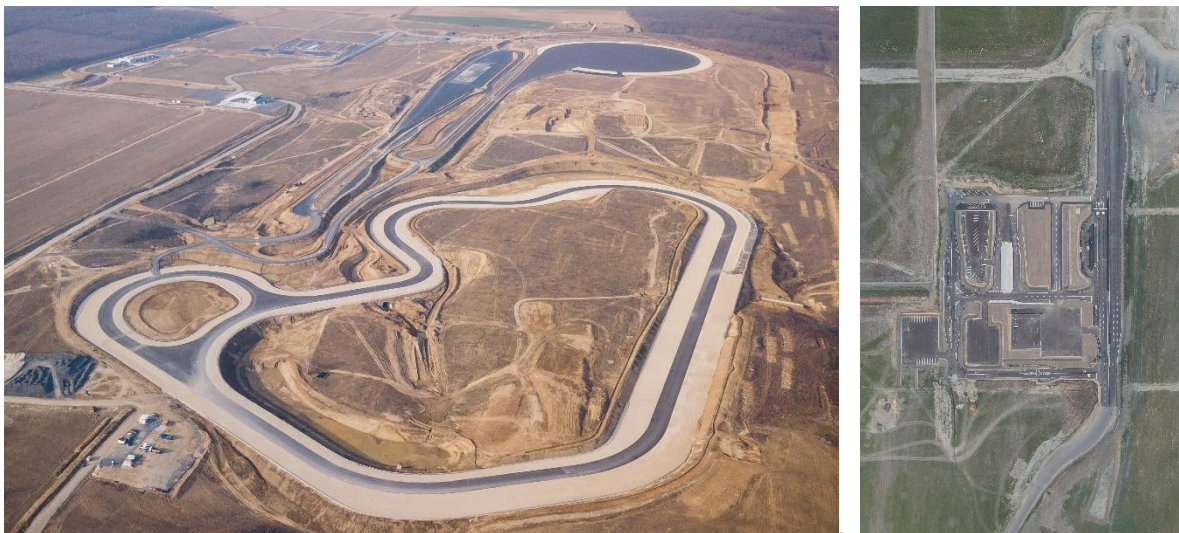
Abbildung 22: Testgelände ZalaZone (Ungarn) Gesamtansicht und Teilansicht Smart City (Stand Februar 2019)
