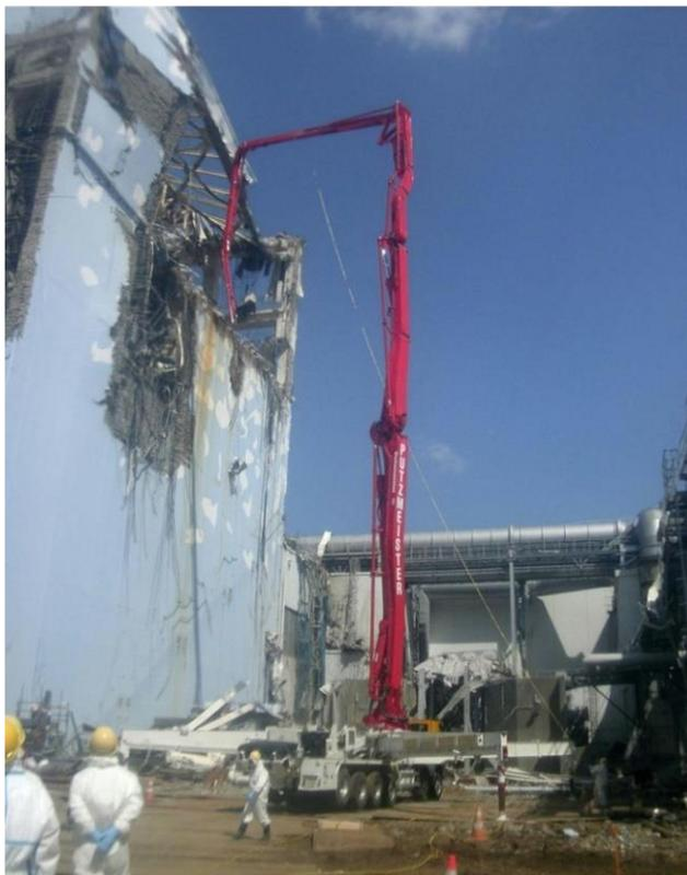
Abbildung 1: Eine Betonpumpe transportiert Wasser in das Abklingbecken des schwerbeschädigten Block 4 des Atomkraftwerkes Fukushima Daiichi ein. (Foto: TEPCO)
