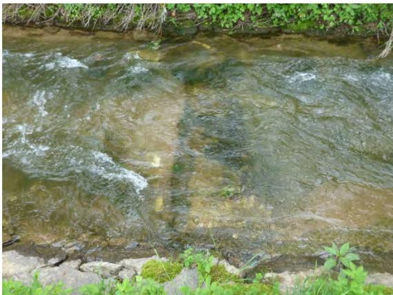
Abbildung 8: Sohlgurte aus Beton.
