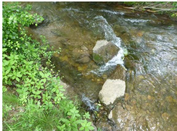
Abbildung 9: Eingebrachte Stör-/Belebungssteine sorgen für eine Tiefenvariabilität.
