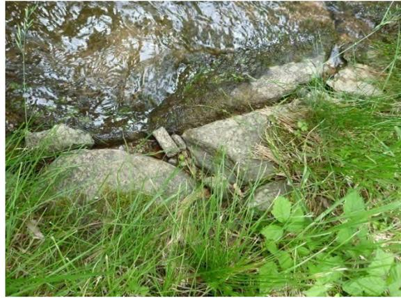
Abbildung 19: Böschungssicherung unverfügt.
