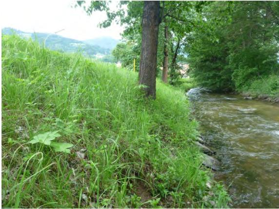
Abbildung 12: Die Böschungsneigungen reichen von 1:1 (v.a. linksufrig neben der Straße) bis etwa 1:2.
