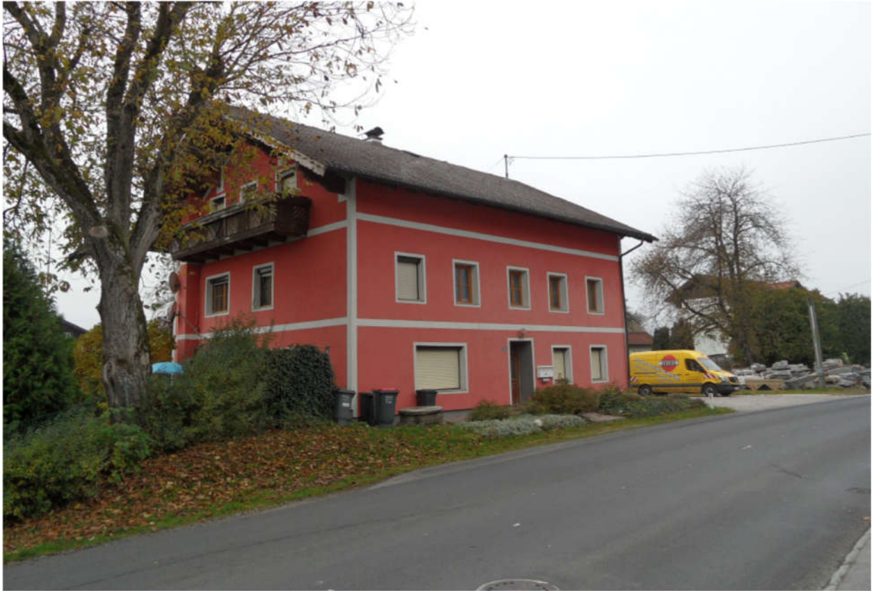
Abbildung 15: Bahnhofstraße 21, Blickrichtung Bahnhof
