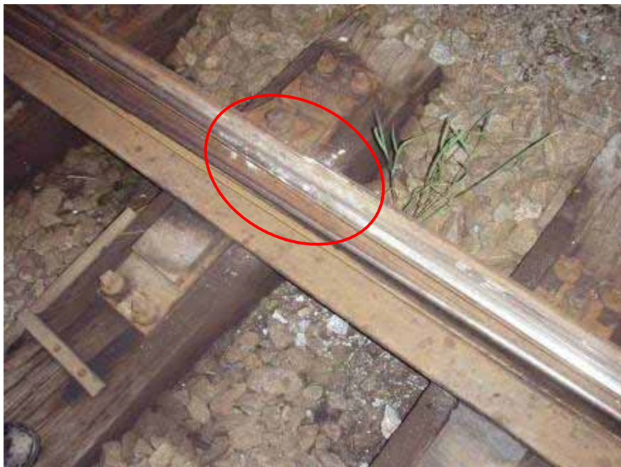
Abb. 12 Stein durch Gewalteinwirkung zwischen Zungen- und Backenschiene gedrückt
