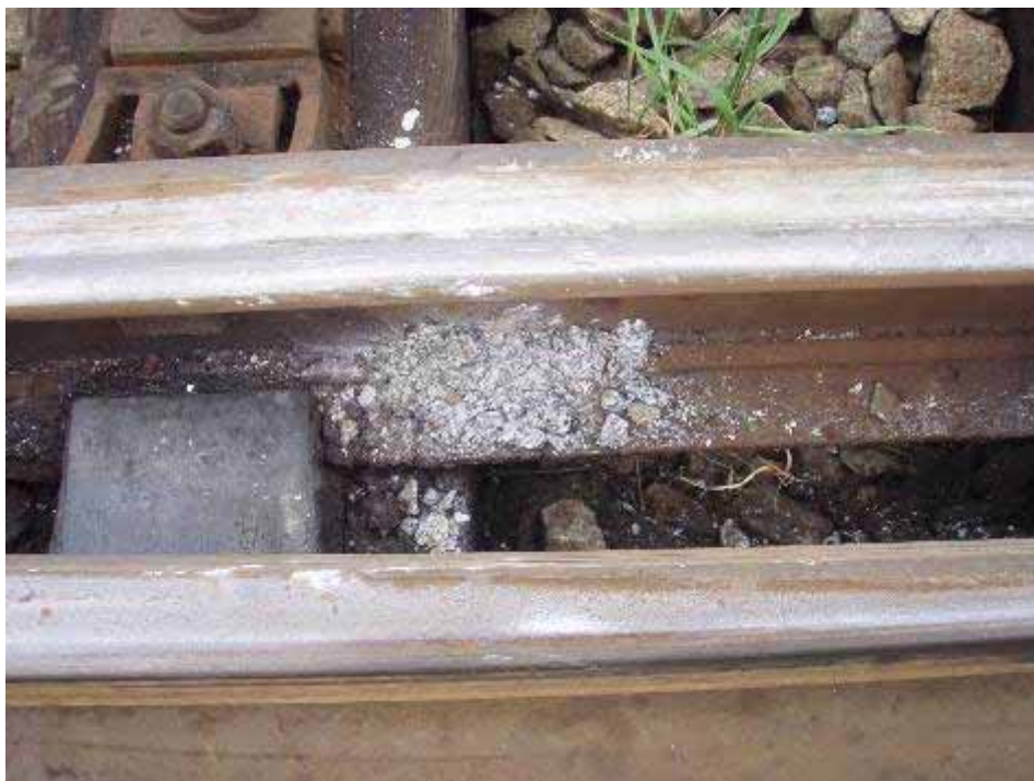
Abb. 14 Zermalmte Steine am Fuß der Backenschiene
