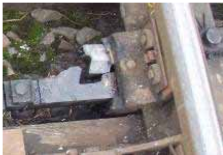
Abb. 17 Weiche 2 Verriegelung am rechten Schienenstrang
