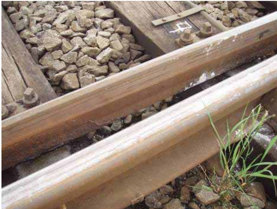
Abb. 13 Weiche 2 Anpressfläche der Zungenschiene
