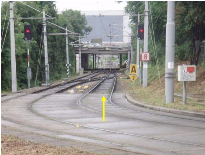
Nach der Entgleisung: Übergang Rillen-/Vignolschienen im km 2,5
