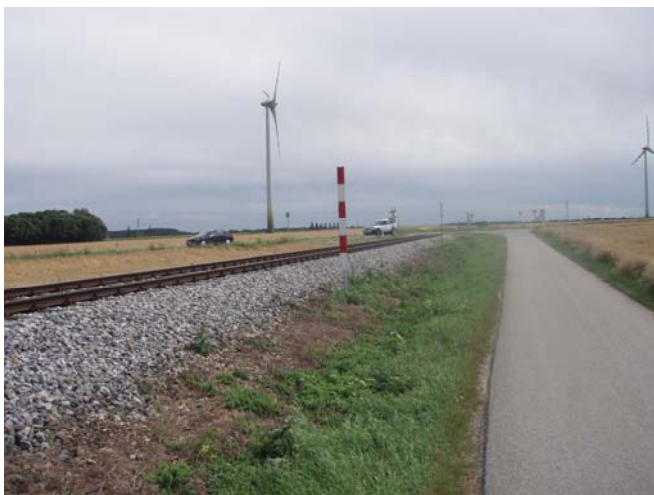
Pfeifpflöck für EK km 2,752 Standort ca. km 3,100
