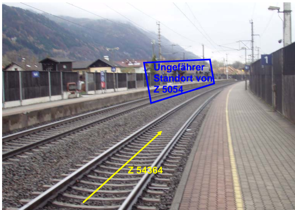
Abbildung 2 Hst Kuchl Blick Gl 1 in Fahrtrichtung 2 (Z 54364)
