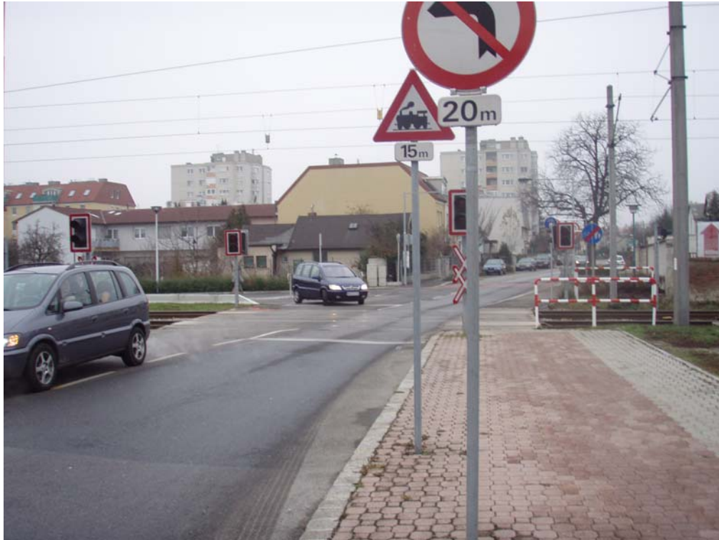
Abbildung 3 Ansicht von Kreuzung Triesterstraße (B 17) / Friedrich Schiller-Straße
