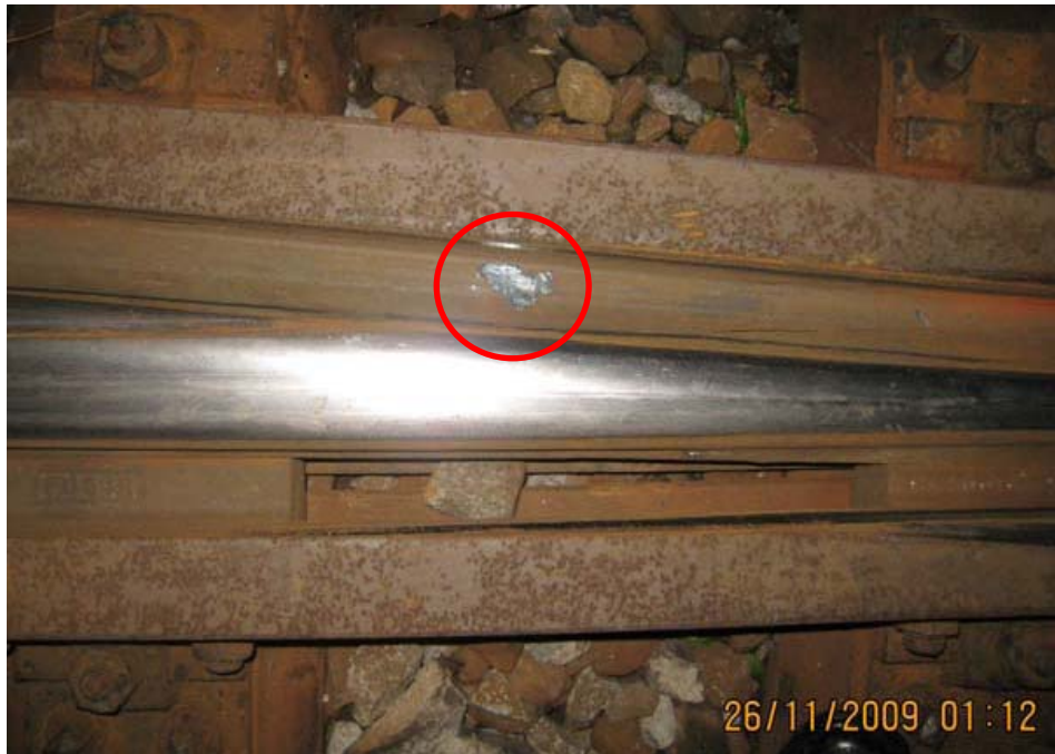
Abbildung 3 Absplitterung des Hemmschuhes im Weichenherz der W 54
