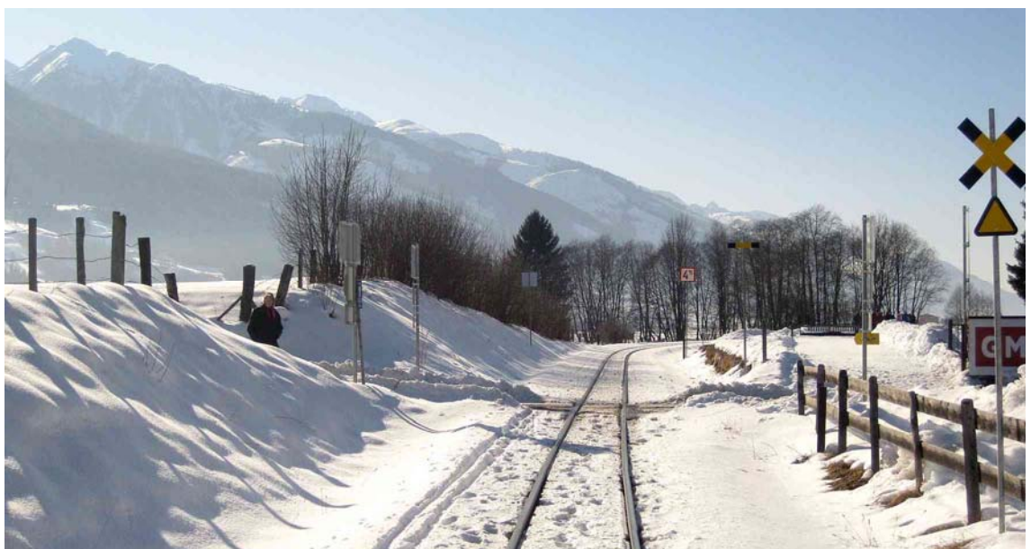
Abbildung 3 Blick auf die EK km 9,131 aus Sicht von Z 3312 - Quelle SLB
