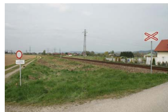
Abbildung 10: Sicht in Richtung Braunau am Inn
