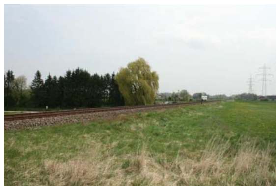
Abbildung 9: Sicht in Richtung Mining
