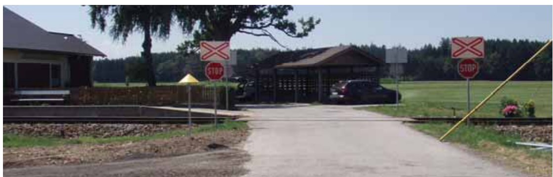
Abbildung 4 Ansicht der EK von rechts der Bahn
