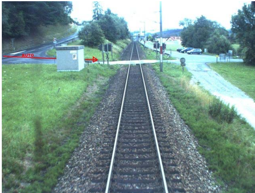
Abbildung 4 Situation vor Ort (Quelle: ÖBB Infrastruktur GmbH)
