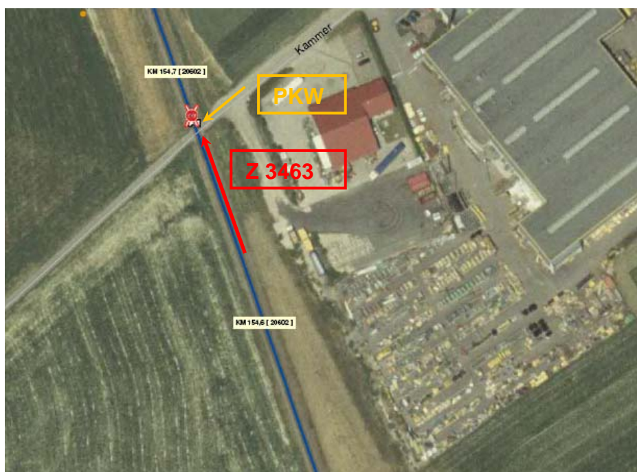
Abbildung 4 Situation vor Ort (Quelle: ÖBB)
